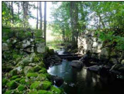
Figur 10. Damm som utgör vandringshinder (tabell 3, hinder 6).
